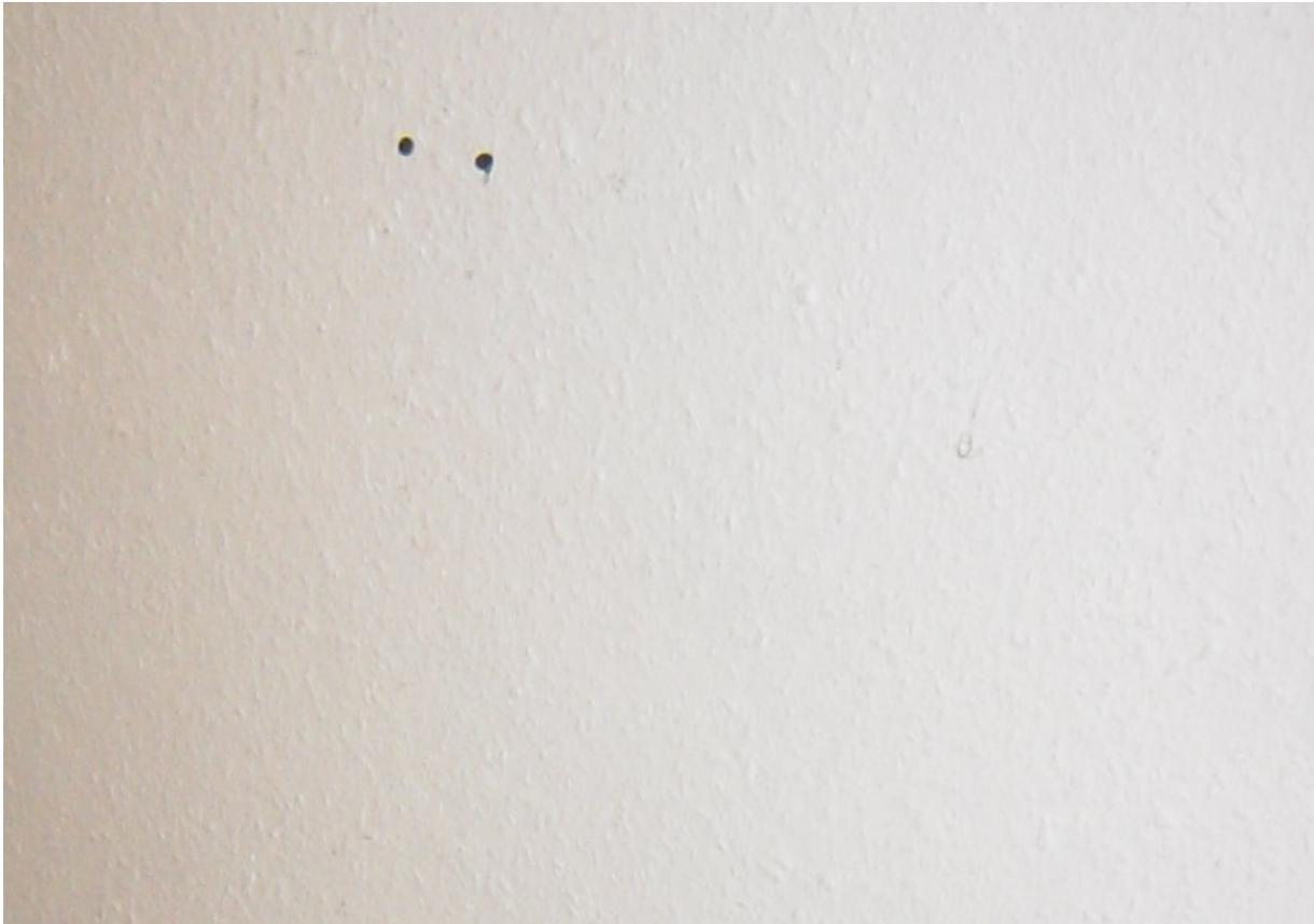
**Abbildung 1: Wand hinter der abgerückten Kommode mit eingeschlagenen Nägeln für die Feuchtemessung**
