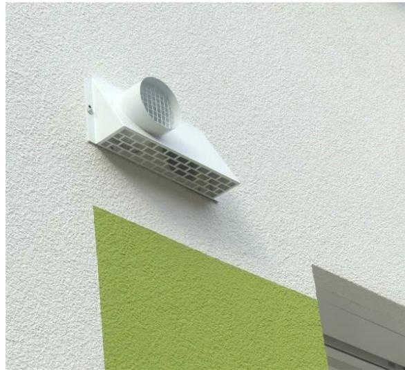
**Abbildung 15: Einfacher Stufenschalter in einem Wohnungsflur für die Auswahl der drei Lüftungsstufen (links). Kombiniertes Außen-Fortluft-Element auf der Außenfassade (rechts).**
