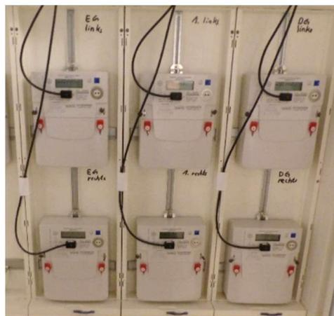
Abbildung 22: Fenstergriff mit EnOcean Funktechnik zum Senden der Griffstellung (links). Stromzähler der Einzelwohnungen mit aufgeklebten Ausleseköpfen (rechts).
