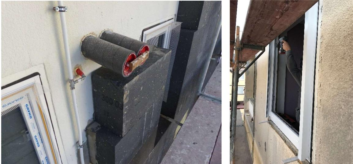
**Abbildung 9: Montage der Außendämmung an der Fassade und Montage der neuen Fenster.**
