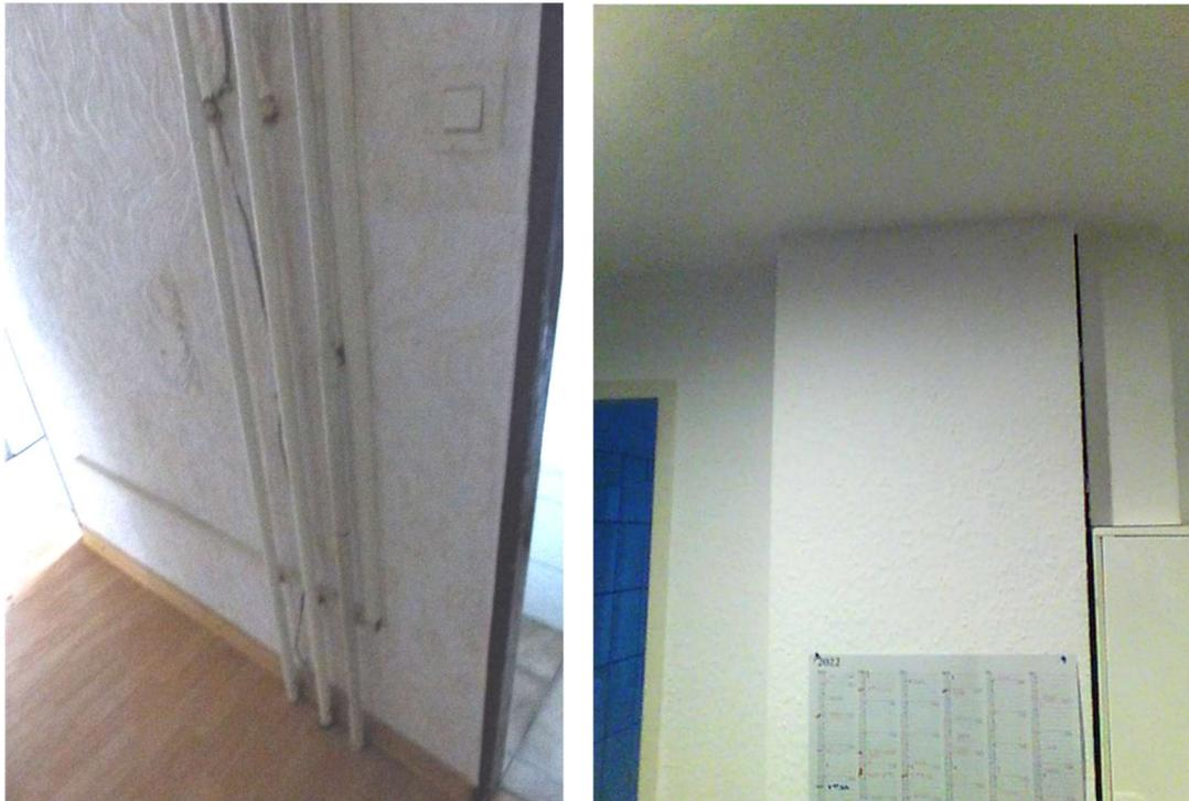
**Abbildung 72: Steigleitungen der Fernwärmeversorgung vor (links) und nach der Sanierung (rechts)**
