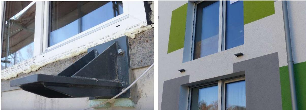
**Abbildung 17: Anker für die neue, freistehende Balkonanlage vor und nach der Dämmung der Fassade. Diese Anker stellen eine massive Wärmebrücke dar, welche in der Bilanzierung berücksichtigt werden muss. Vorzuziehen wäre hier eine in der Substanz bessere thermische Entkopplung. (Vgl.: [Schulz 2007])**
