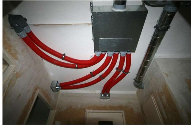
**Abbildung 13: Lüftungsgerät einer Wohnung an der Küchendecke vor der Verkleidung und Rohrmontage (links). Luftverteilung an der Flurdecke vor der Montage der abgehängten Decke (rechts)**
