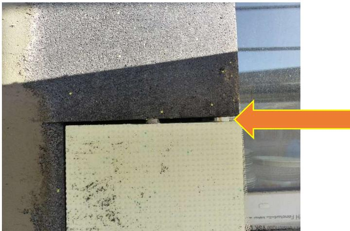
**Abbildung 28: Luftspalt zwischen zwei Dämmblöcken der Außenfassade an einem der Nebengebäude.**
