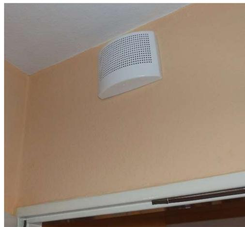
**Abbildung 14: Fertig verkleidetes Lüftungsgerät an der Küchendecke (links). Montiertes Zuluftelement in einem Wohnraum kurz unter der Decke (rechts).**
