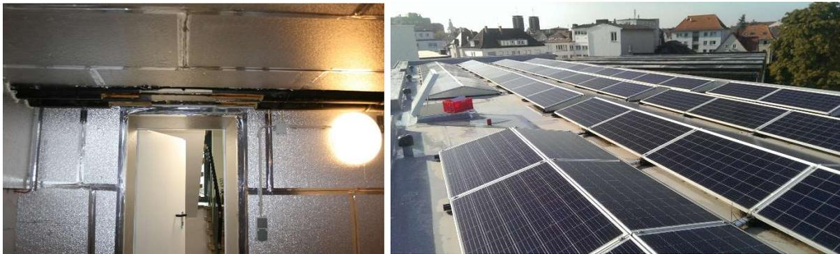
**Abbildung 10: Montierte Wärmedämmung der Kellerdecke und Begleiddämmung an den Kellertrennwänden (links). PV-Anlage (29 kWp) auf dem neuen Flachdach (rechts).**
